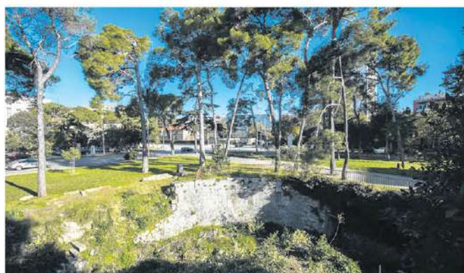
Parte del muro di cinta
