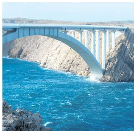
Il ponte di Pago
