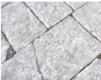
Pavimentazione romana in piazza Marafor
