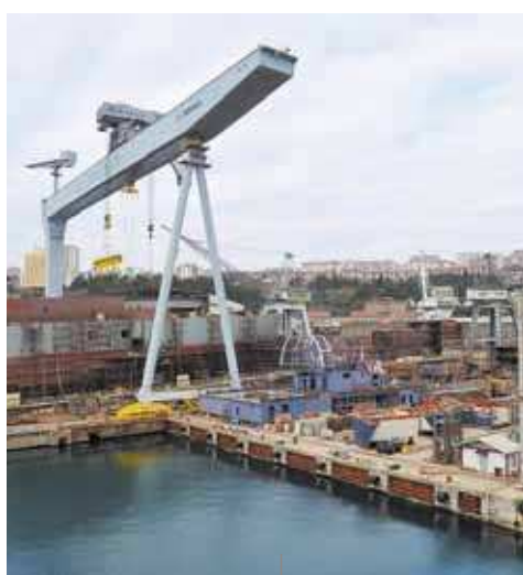
Il cantiere "3. maj" a Cantrida
