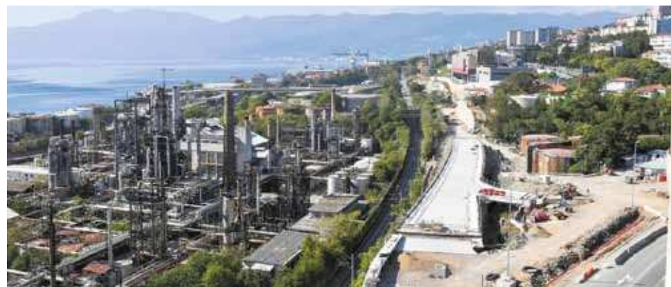
Gli impianti della Raffineria in Mlaca
