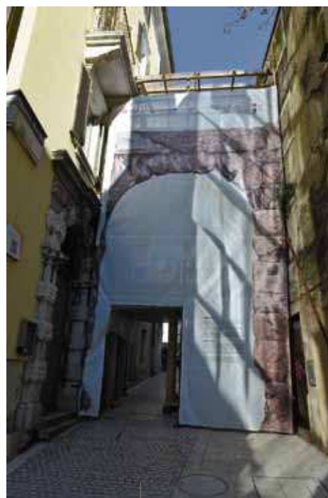
L'arco romano è soggetto al restauro
