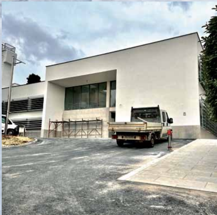
SMSI Leonardo da Vinci di Buie, lavori in corso
